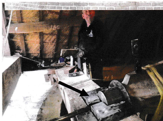
Molenbouwer bouwt nieuwe Pensteen in.
